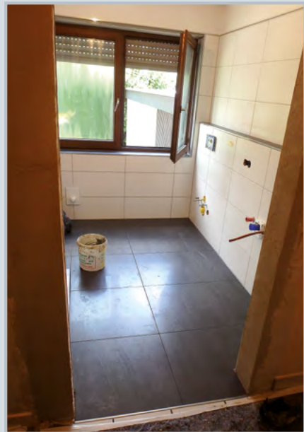
Der Boden wird gefliest
