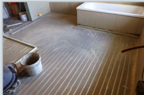
Elektrische Fußbodenheizung
