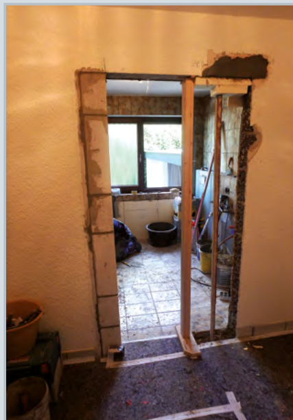
Die Tür wird versetzt und vergrößert
